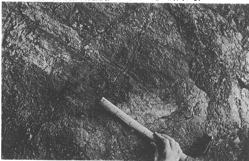
⑦凝灰岩の表面にみられる断層鏡肌と動いた方向を示すひっかき傷(ハンマーの柄の方向)
