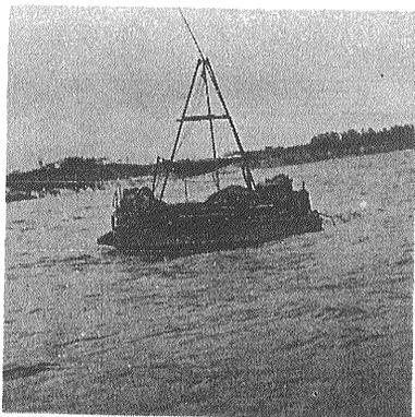
④ 荒天のとき港外にアンカーされ 波のまにまに浮遊しているポンツーン(アンカーは2本降している)
