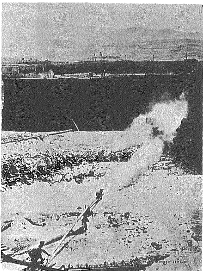
②アングレン炭砒で水力探炭中のハイドロモニター (今日のソ連邦)
