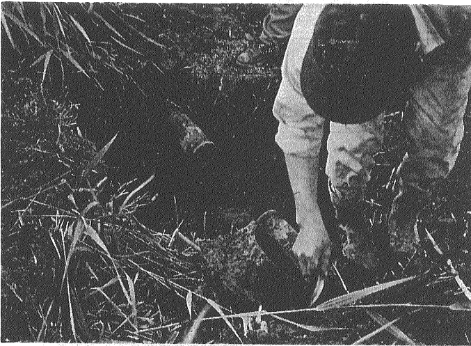
㉞ガス輸送管の破損(新潟県村上市岩船町 村上市災害対策本部提供)
