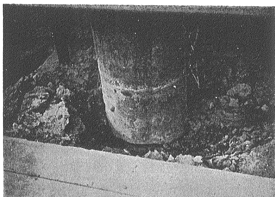
⑩通産省地盤沈下観測井の抜け上がり(約30cm)(新潟市大形)
