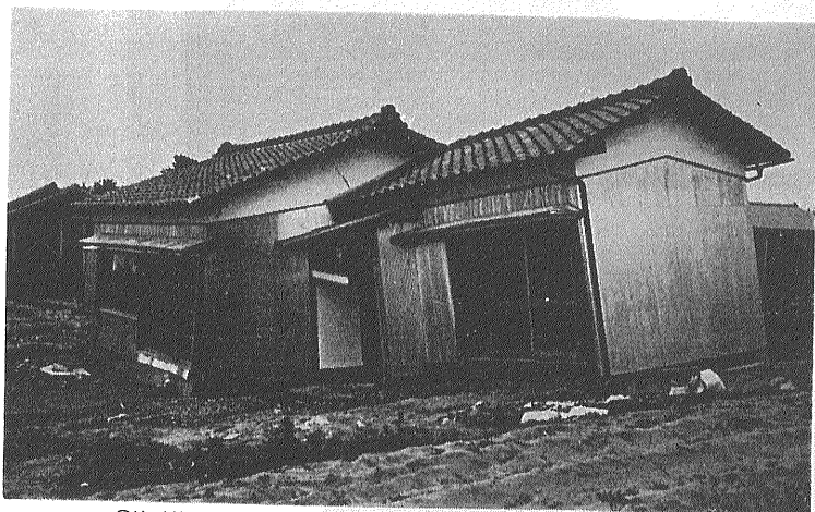
⑳地割れにより破壊された家(新潟県西蒲原郡黒崎村善久付近旧河道内)
