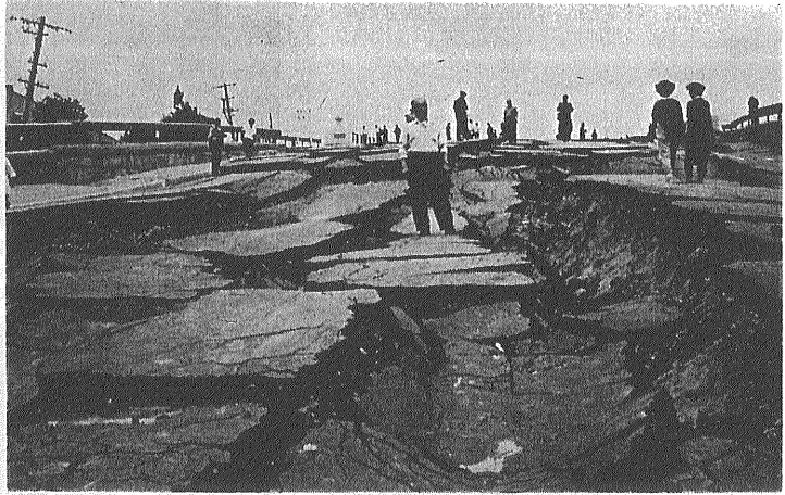
↑ ㊦ 昭和橋南たもとの 地割れ。両側の擁 壁は開き顕著な不 等沈下を生じている
