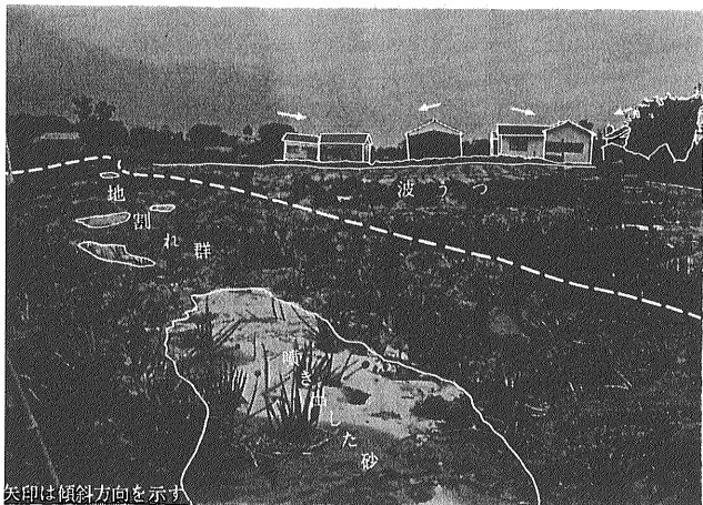
⑧西蒲原郡黒崎村喜久 旧信濃川沿いにゆるく波状にうねった局部沈降隆起 3軒の家は波面に順応して傾斜している 多くの南北性地割れを伴う手前に白く見えるのは噴出した砂
