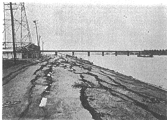
⑬新潟市白山駅南東方信濃川北岸埋立地 河道に平行して発達した地割れ群 道路面が河道に向かって傾斜すると同時に押し出された(第38図参照)
