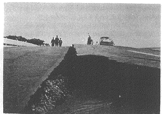
⑮ 地割れ(新潟県白根市大野橋白根側の道路破損) (白鳥一典撮影)
