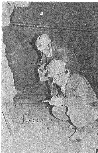
坑内における地質調査
