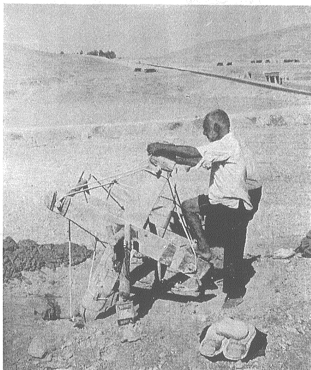
カナートの改修作業 (テヘラン郊外にて)
