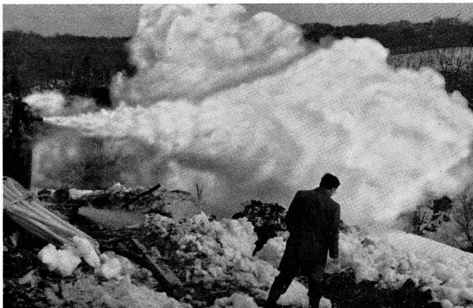
→ セパレーターから噴出する蒸気
