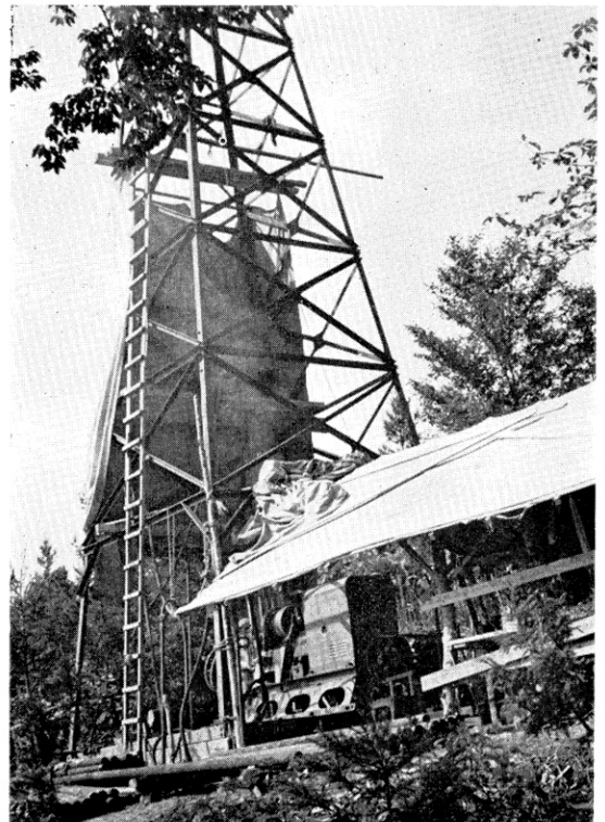
鬼首第3号井の掘さく現場
