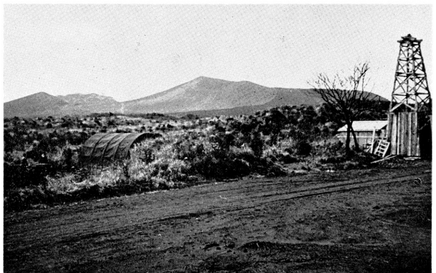
伊豆大島外輪山内の地熱ボーリング
