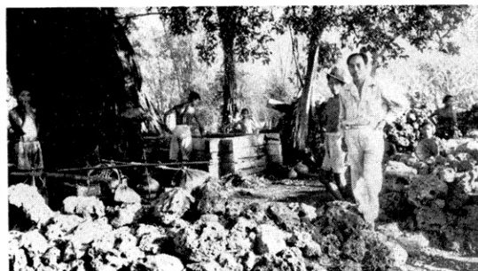
大きい石灰岩地帯には地表水が少ないだが石灰岩の岩体の中に含水部のあることが多い泉の所に掘り込んだ井戸で村人たちは井戸端会議をやっている
