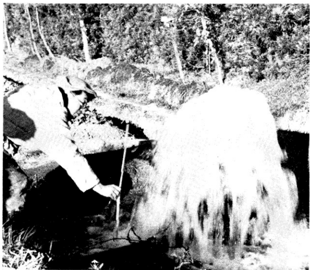
大井川町下小杉の自噴井 簡易水道水源にする予定で掘られたが水道工事遅延のため 約半年間もむだに水を流している
