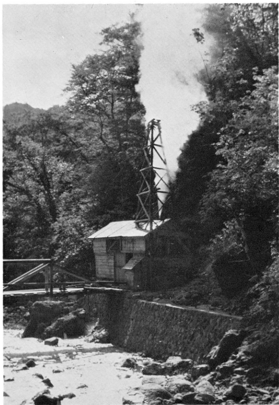
映雲荘へ温泉を供給している 試錐7号井 (地下160m~300mの深さから噴出している天然蒸気)
