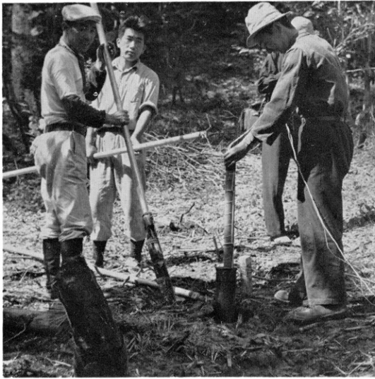
火薬 (5kg) を爆鉱孔に挿入する
