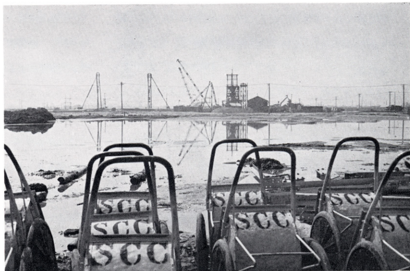
しかし細砂遊泥に富む海岸ではいきおい埋立造成地も排水のわるい軟弱地盤とならざるをえない
