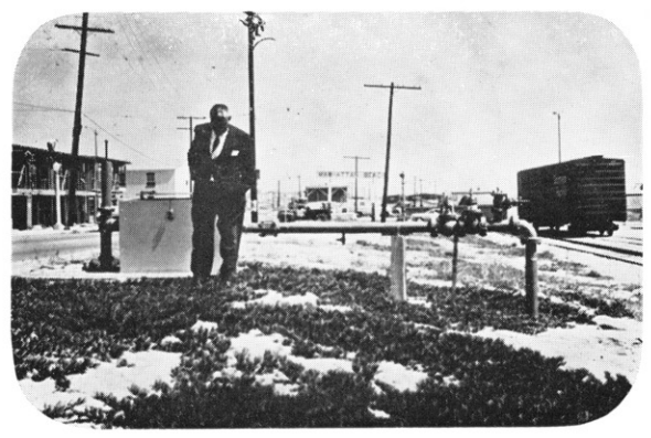
マンハッタンビーチ市の水道地下水圧入用井戸 現在12本の圧入井戸群で 15,000 m 3 /日 の水道水を地下に注入し地下水塩水化の防壁をつくっている
