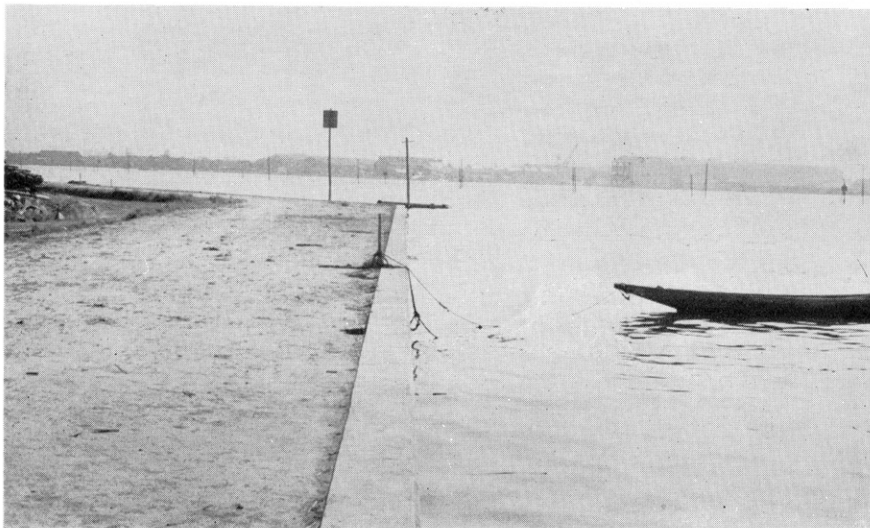
沈下の激しい新潟市山の下護岸付近
