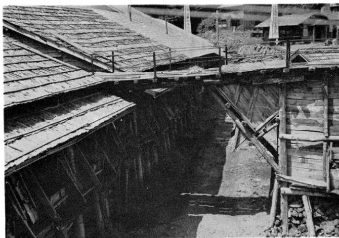
貯 鉱 場 各品位別に貯鉱される (以上野田玉川鉱山提供)
