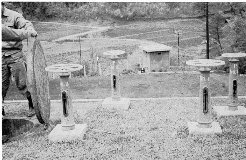
各井戸の水が集まる集水池 それぞれの井戸の揚水量を加減して絶えず排砂の有無などを調べることができる
