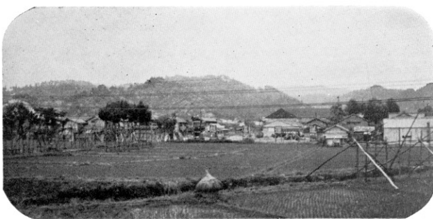
南側に油田第三系からなる山が連なる（かも付近）
