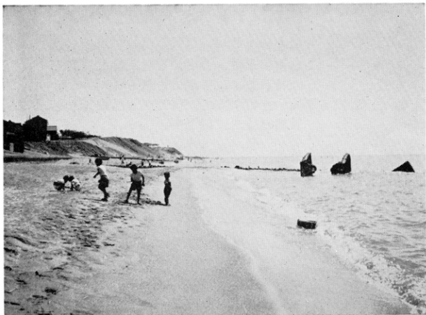
波に洗われる旧新潟測候所の建物の残骸
