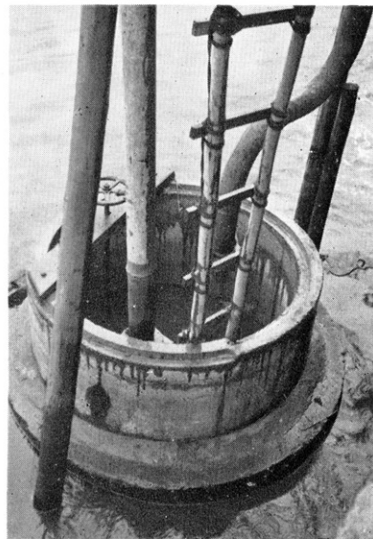
塩水を揚水し製氷冷凍の用水にあてている工場用水源の1例
