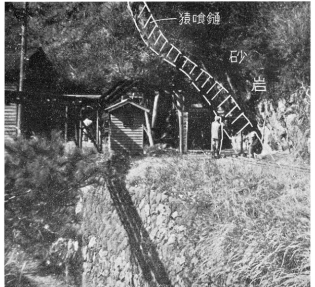
静岡県河津鉱山2番坑坑口における鉱脈露頭
