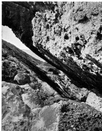
砂質頁岩の部分が太平洋の黒潮に侵蝕されている牟婁層群（和深付近）
