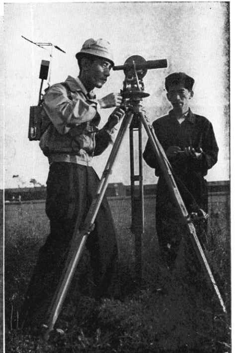
トランシットで基点導標の測量中 (背中の無線電話機で指示)
