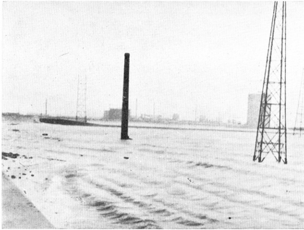
地盤沈下で海中に没した工場（大阪市此花区）
