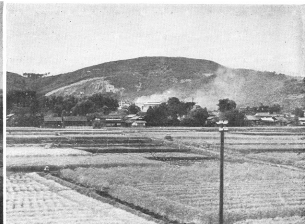
赤坂の石灰山と白く化粧された石灰工場
