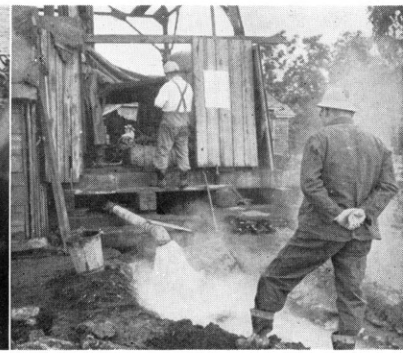
ガスと温泉の自噴 (北海道長万部 試掘1号井)
