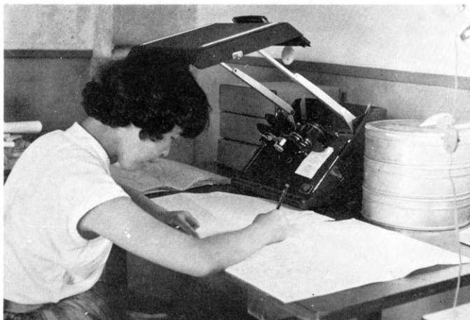
空中写真のフィルムをマイクロリーダーにて拡大し 地図と対象して航跡を修正していく
