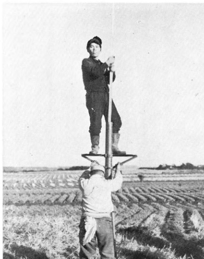
砂鉄簡易ボーリング作業
