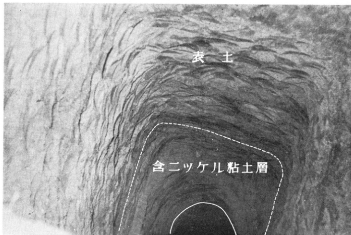
含ニッケル粘土層を坑井により探鉱したもの 深さ13m (宮川 鉱 山)
