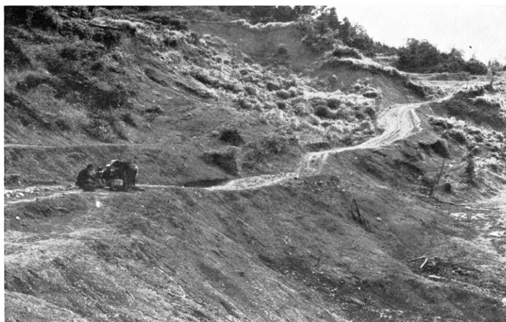
新潟県東頸城郡川井沢地すべり地帯で 電探をはじめるところ 果道はすべり落ちてでこぼこになっている
