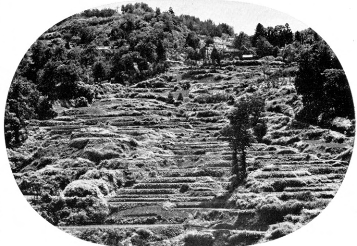
地すべり地特有の階段状の水田 いわゆる棚田であ る 地すべりの頭部にある家屋はすでに傾いている
