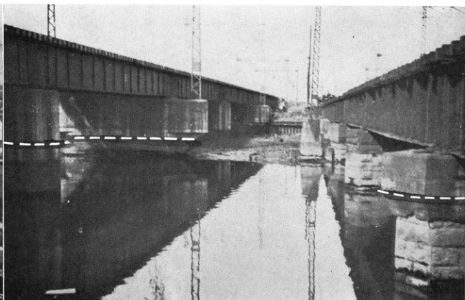
鶴見川の地盤沈下 東海道線の旧橋(右)が1m程高い新橋(左)につけ替えられている 氾濫時には白線のところまで水に浸る
