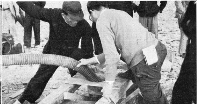
地下水補強のための加圧注水のテスト
