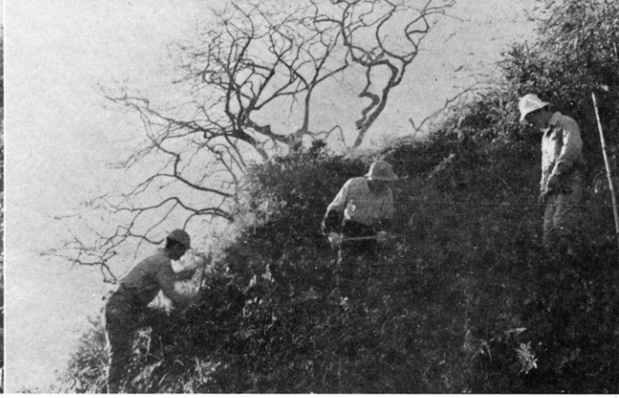
調査の進捗に伴ない表土剥も次身に険しい 山腹から山腹へと行われ、露頭を追跡する
