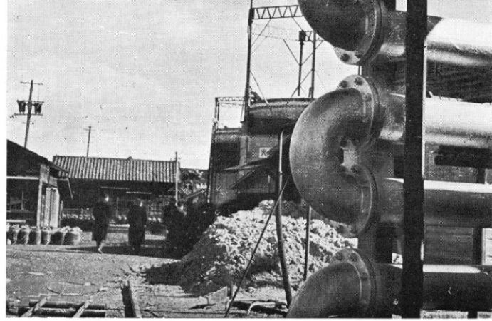
クロルメタン工場の一部 手前はエヤークーラー、右後方ガスタンク二基中間の白い山は酸性の排水を中和するに使われるカーバイドのガス
