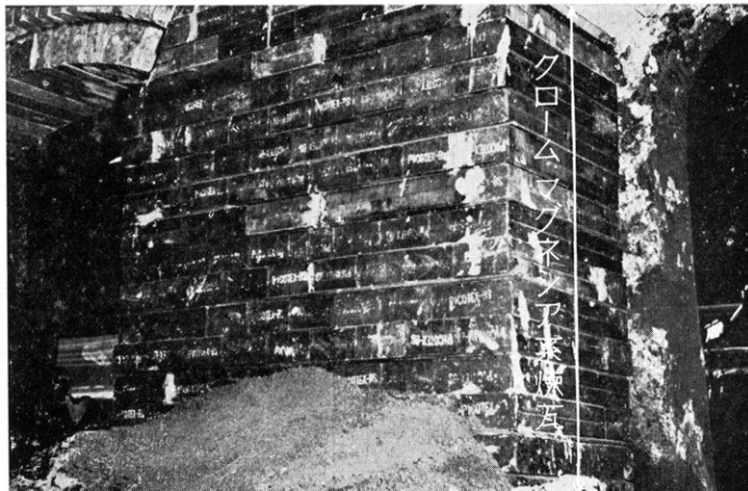
平炉前壁の内側 (大阪製鉄 K.K. 提供)
