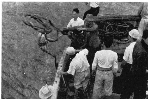
電線には 30~40 cm 毎に船型の ビニールの浮きが付けられている
