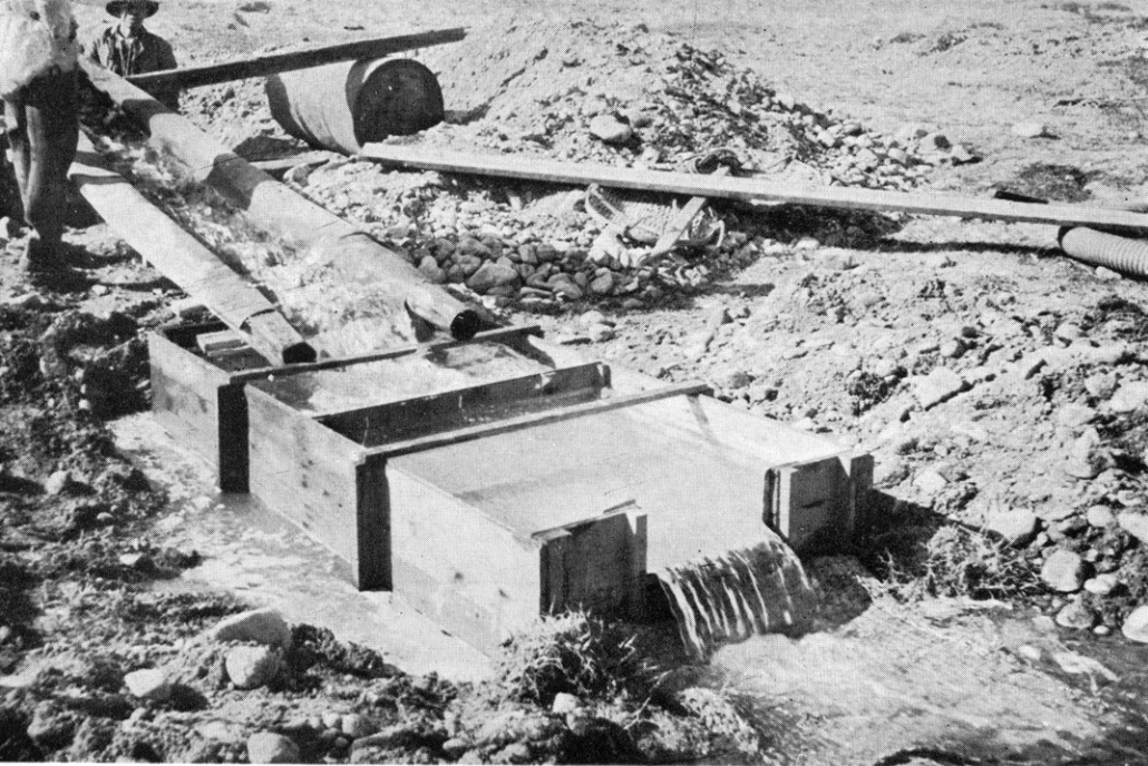
所内第1回写真コンクール入選作 「揚水試験」 地質部 村下敏夫
