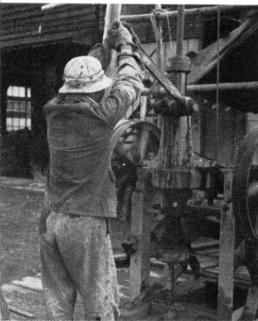
回転式型500m 試験機で掘さく中
