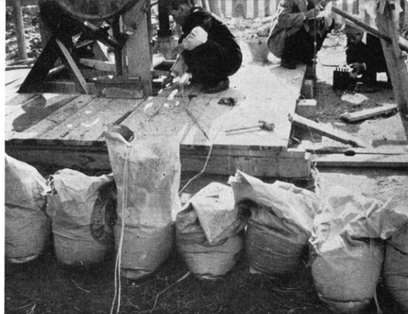
孔内の電気検層
