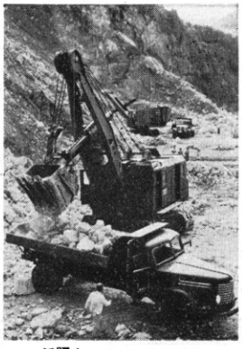
活躍中のパワーショベル (石灰石鉱業協会提供)
