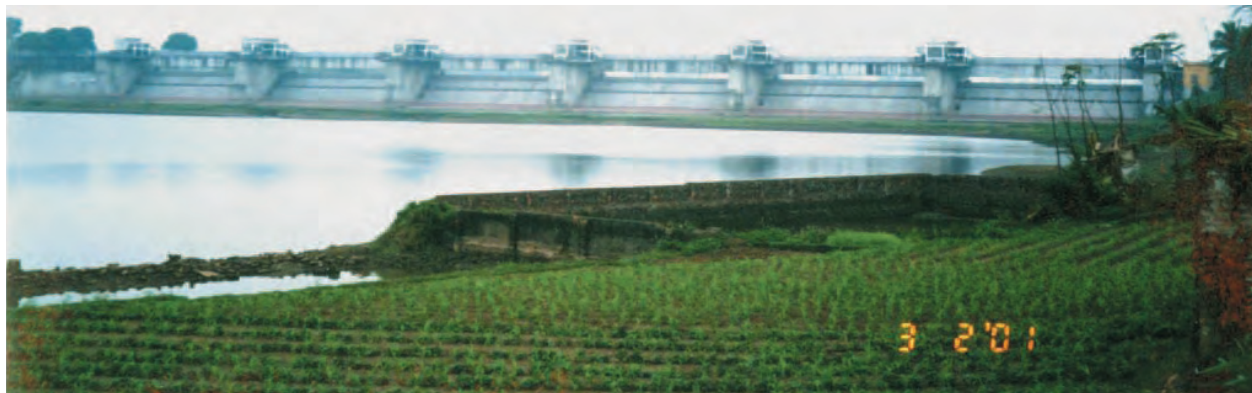
写真4 ダイ川・紅河を分断するダム堰。1934-1937年に建設され、1975年に改修されている。この上流には1968年に建設された可動堰が存在するが1971年の既往災害洪水以降、開門されることはなかった。現在も水面は湿地帯のようになっており、雨季でも歩いて渡れるほどの深さしかない。
