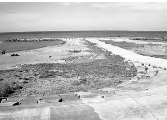
写真23 三里ヶ浜では巨大なヘッドランドの建設が進められていました。
