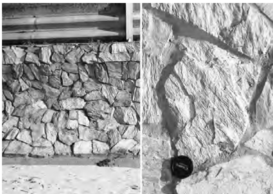
写真12 砂防壁に貼られた結晶片岩の薄板(鉄平石)、色は赤や青、緑とカラフルです。
