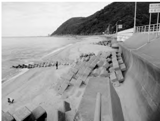
写真25 寒川海岸. 護岸の下にテトラポッドが並び、砂浜はやせ細っていました.
