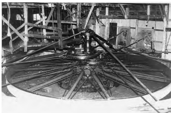
写真6 豊川3PPポンピングパワーユニット。
