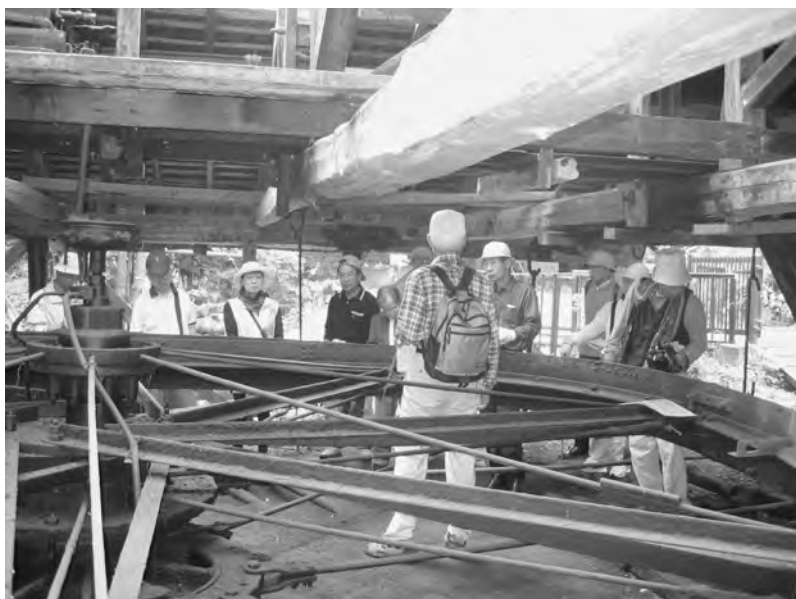
写真3 二段式ナショナル・ポンピングパワー。
