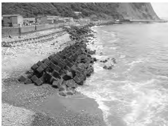
写真30 幌満川河口浜。護岸堤とテトラポッドの間に砂礫の浜がわずかに残っている。
