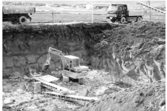
写真2 畑地でのカオリンの採掘。ベルト・コンベアで道路のダンブ・トラックへ積み込まれる。
