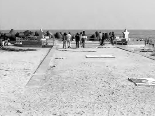
写真29 海浜公園のヘッドランド。一部が崩壊して、立入禁止となっていた。
