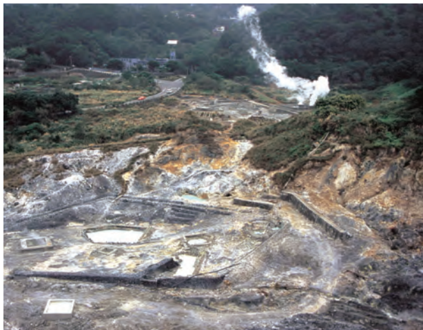
写真14 北投温泉東方の硫黄谷。温泉が造成され、分岐され、各施設に配湯されています。
