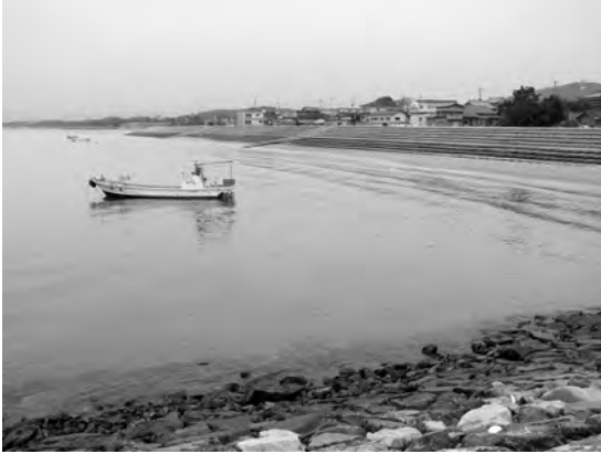
写真5 長井浜、階段状護岸堤の下に、狭い黒砂の砂浜が残されている。
