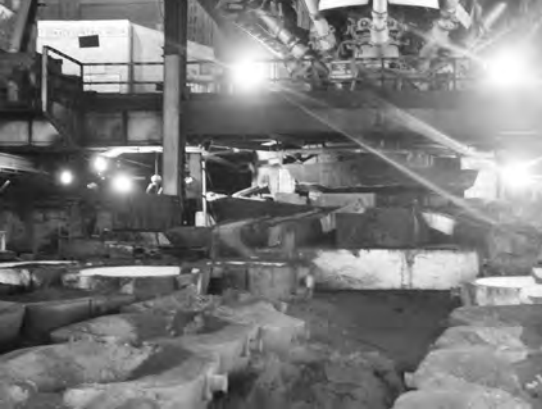
写真6 高炉(奥)と受け皿(手前).
