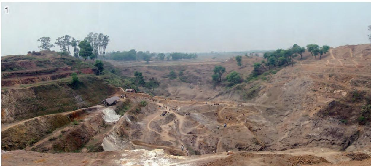
写真1 ベルディ鉬床全景。ピットの底部に厚さ10m程度の鉬体を胚胎する。出荷鉬石の品位は10-35%  $P_2O_5$  で，年間約16,000トン生産している。西ベンガル州では約46万トンの埋蔵量が見積もられている (Indian Bureau of Mines, 2006)。
