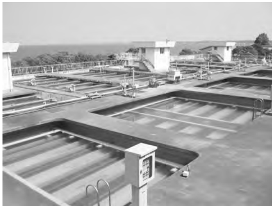
写真10 水道水の沈殿槽。
