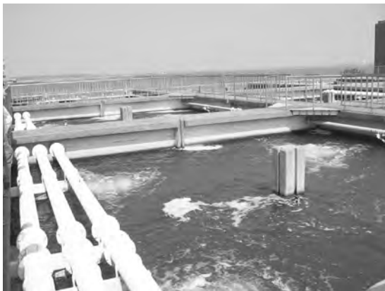
写真9 上水道処理用の生物処理施設。
