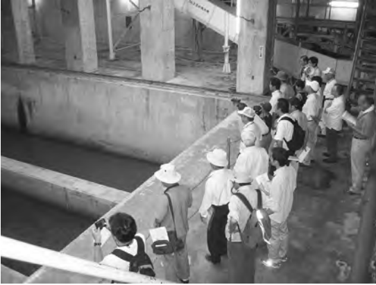
写真4 下水管からの原水と沈砂池。
