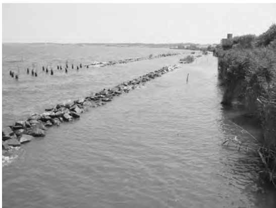
写真3 多自然型護岸。
