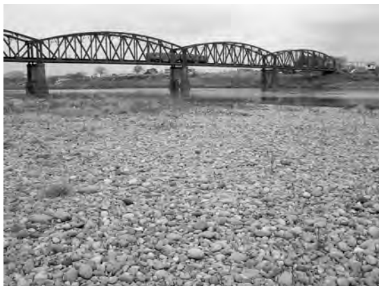
写真1 木曾川の河原。愛知県一宮市の名鉄本線「木曾川堤」駅付近。
