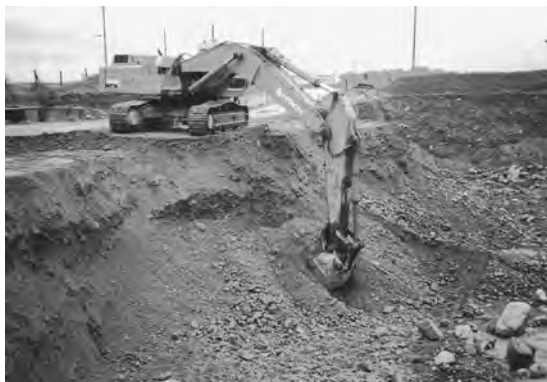
写真12 扇状地における重機での砂利採取。地下水位が低く、湧水は見られない。
