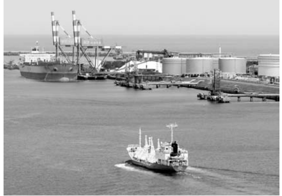
写真12 鹿嶋港風景。港入り口の石油タンク群。大型船・小型船の出入りで賑わっている。
