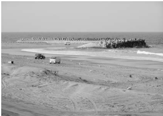
写真6 建設が進むヘッドランド。シーサイド・パークの北約350m北の海岸。
