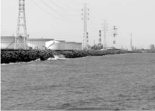
写真18 鹿嶋港埋立地の海岸。護岸の下にテトラポッドが並べられた海岸が延々と続いている。
