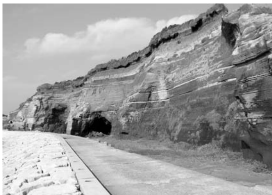
写真16 護岸工事の進む屏風ヶ浦。花崗岩の大塊が積み上げられている。
