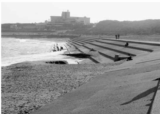
写真23 君ヶ浜中央部の浜. 砂が失われ緩傾斜防波堤に波が打ち寄せている.
