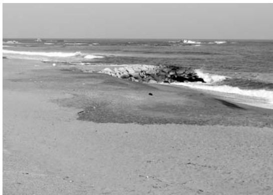
写真24 君ヶ浜にある砂に埋もれた突堤.
